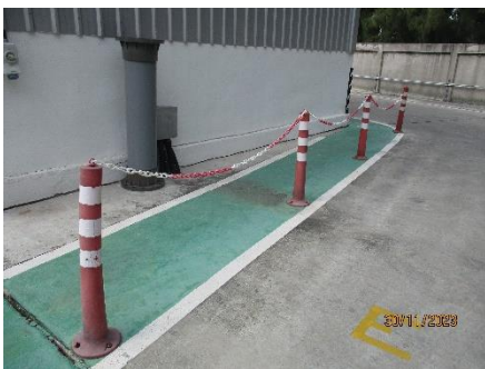
ภาพที่ 2.2-41 สิ่งกีดขวาง (Barrier) ป้องกันการเกิดอุบัติเหตุจากยานพาหนะ
