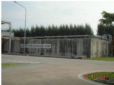
ภาพที่ 2.2-32 บ่อน้ำสำรองขนาด 1,200 ลูกบาศก์เมตร
