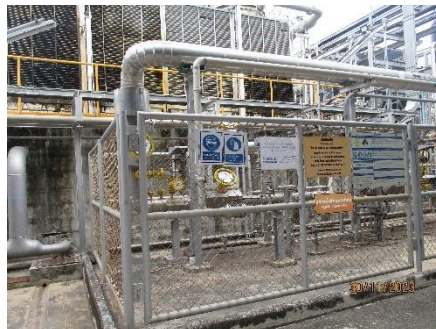
ภาพที่ 2.2-43 การปิดกั้นพื้นที่ตลอดแนวการวางท่อ
