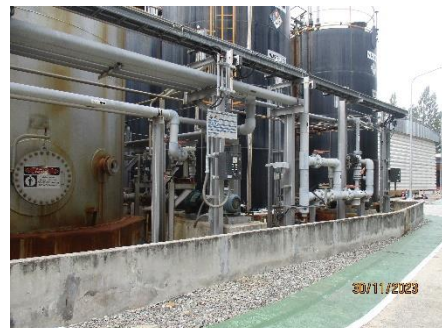
ภาพที่ 2.2-37 คันกัน (Dike) คอนกรีตล้อมรอบ ถังเก็บสารเคมีบริเวณถัง
