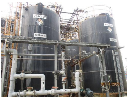
ภาพที่ 2.2-11 HCL Storage Tank
