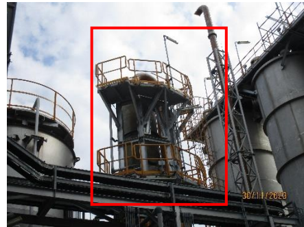
ภาพที่ 2.2-2 หอกำจัดคลอรีน (Chlorine Eliminator)
