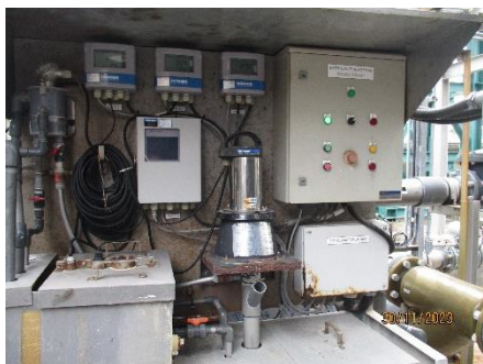
ภาพที่ 2.2-14 เครื่องมือวิเคราะห์อย่างต่อเนื่อง (Online-Analyzer)
