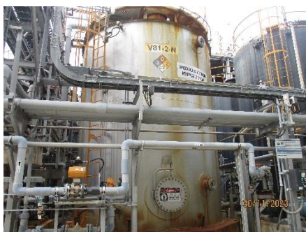
ภาพที่ 2.2-7 บ่อปรับสภาพให้เป็นกลาง (Neutralization)
