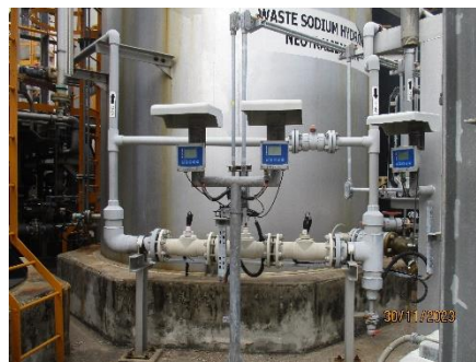
ภาพที่ 2.2-15 อุปกรณ์ ORP Sensor
