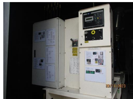
ภาพที่ 2.2-42 แหล่งพลังงานสำรอง (Back up Electrical Generator)
