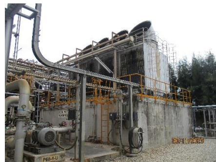
ภาพที่ 2.2-12 หอผลิตน้ำหล่อเย็น (Cooling Water Blow down)
