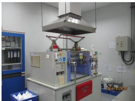
ภาพที่ 2.2-51 ภาพการติดตั้งระบบป้องกันไอสารเคมี (Filter)
